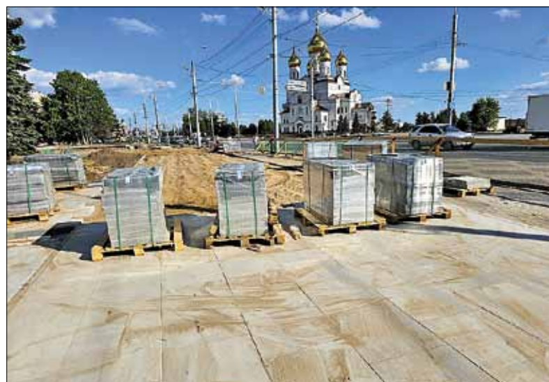
■ На территории около швейной фабрики работы ведутся с опережением графика
