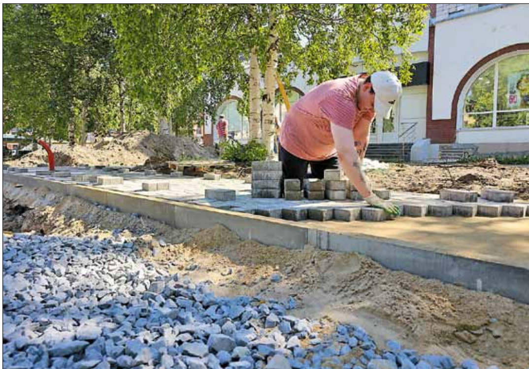
■ В сквере на улице Поморской кипит работа – рабочие планируют территорию и уже приступили к укладке тротуарной плитки
